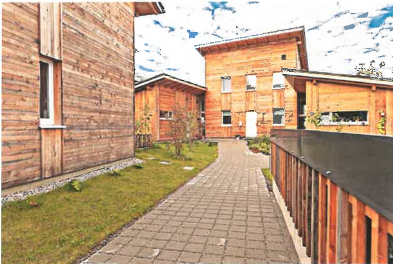
Fünf Häuser á 100 m 2 ausgelegt für vier Personen, Vier Häuser a 75 m 2 - passend für zwei Personen sowie zwei 40 m 2 Single-Wohnungen.“
