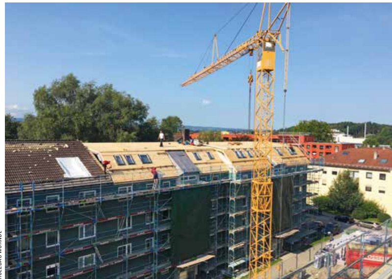
◀ Die neue Dachform ist ein Pfettendach mit 45 Grad steilen Traufseiten, deren Spitzen durch ein abgeflachtes Schrägdach ersetzt wurde
